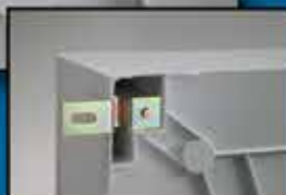
Závěs je možné osadit horizontálně i vertikálně.
